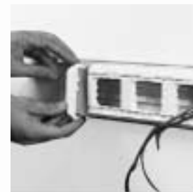
6.-Colocar laterales e instalar mecanismos.
