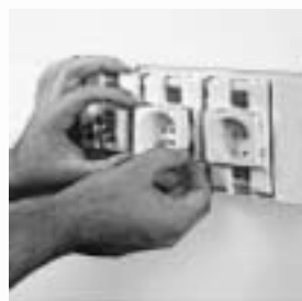
5.-Instalar los mecanismos.
